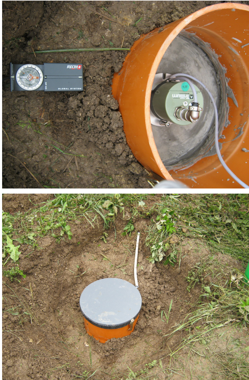
Abbildung 8: Freifeld-Installation einer Messstation des Bernrieder Netzwerks. In einem ca. 0.5-1.0 m tiefen Erdloch wird ein oben verschließbares Kunststoffgehäuse mit einem einige Zentimeter dicken Zementfundament eingegossen. Nach dem Orientieren und Nivellieren des Seismometers wird der Behälter geschlossen und anschließend zur Temperaturstabilisierung wieder mit Erde bedeckt.
