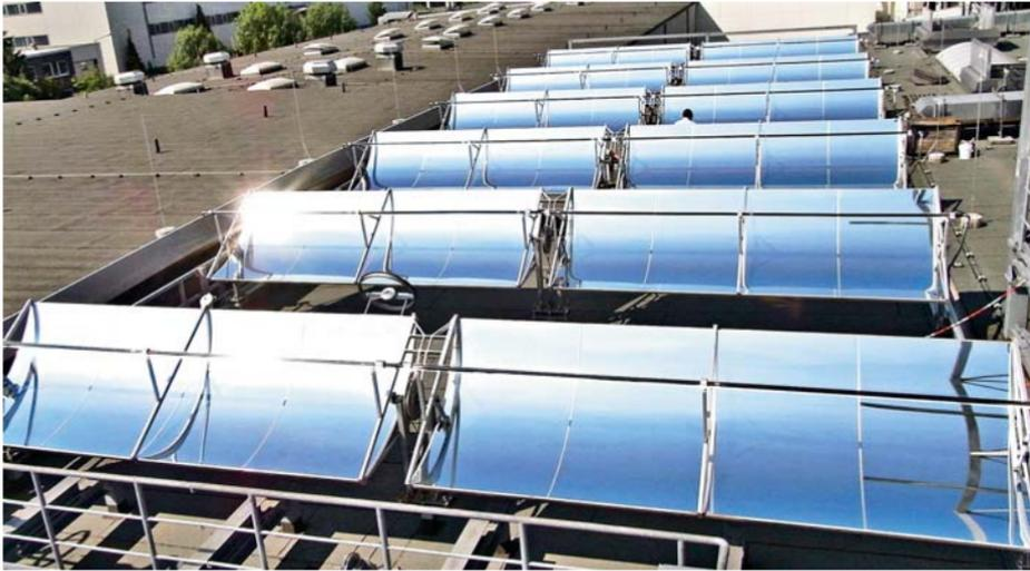
Zwölf Parabolrinnen-Kollektormodule auf dem Dach der Firma Alanod in Ennepetal.
