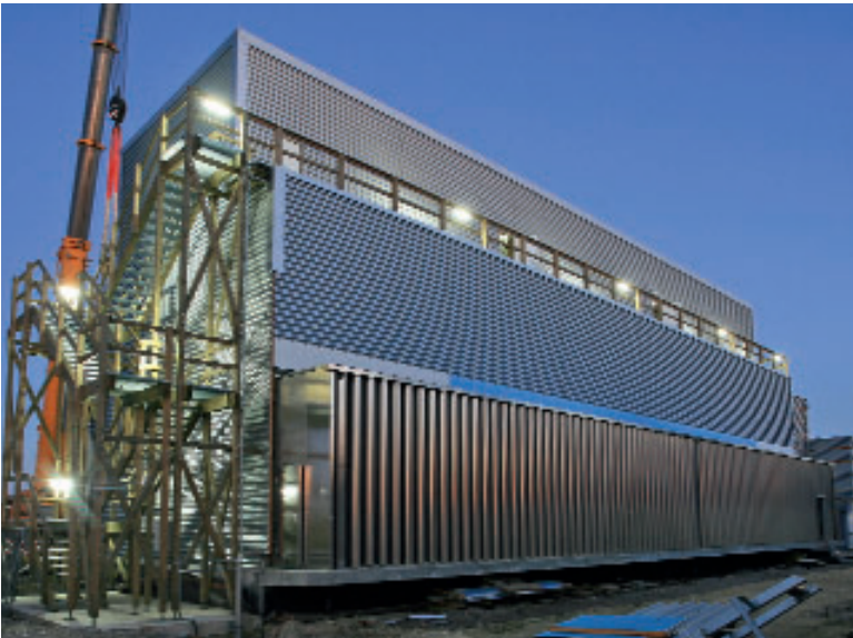
Abb. 4.6 Nasskühlturm in Unterhaching
