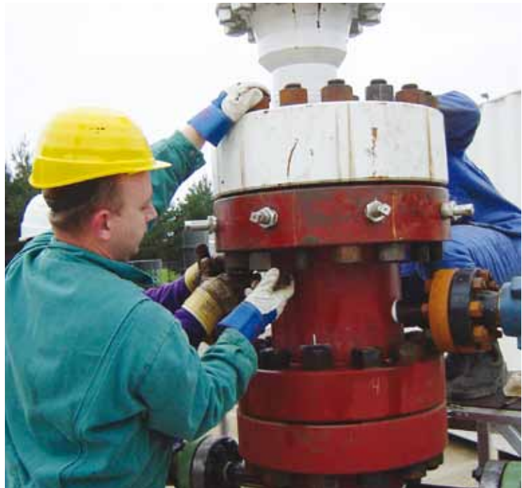
Abb. 9: Arbeiten am Bohrlochkopf
