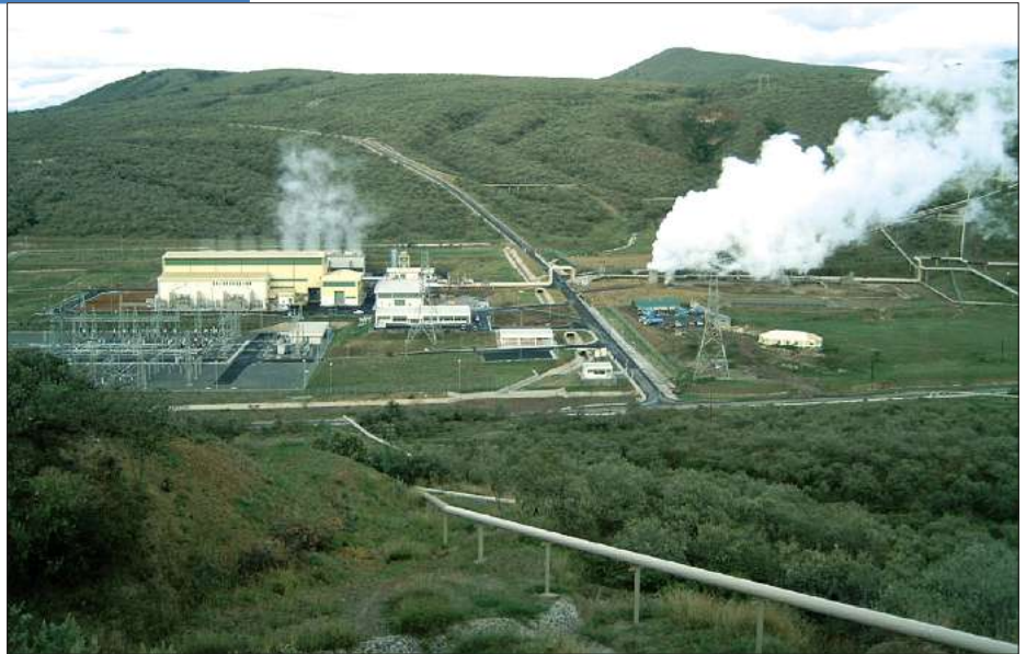
Geothermisches Dampfkraftwerk Olkaria II, Kenia, mit ca. 70 MW elektrischer Leistung.
