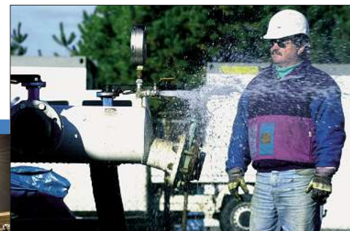
Entlüftung des Saugmanifolds (Horstberg Z 1).
