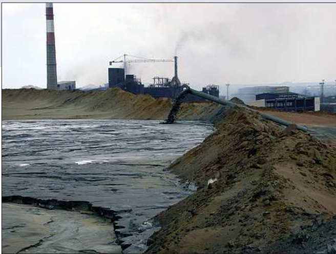
Aufbringen von Aufbereitungsrückständen auf die Berghalde, im Hintergrund sind Erzaufbereitungsanlagen zu sehen.
