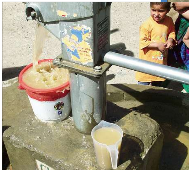
Typische Brunnen mit Handpumpe im Kabuler Stadtgebiet. Teilweise ist das Grundwasser im Stadtgebiet von Kabul von sehr schlechter Qualität.
