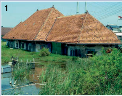
Die Fotos 1 bis 5 verdeutlichen das dramatische Ausmaß der Absenkung von Gebäuden und dokumentieren die verzweifelten Versuche, mit einfachsten Mitteln – Erde, Schutt und sogar Müll – dagegen anzukämpfen.
