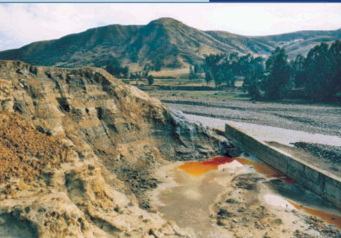
Bergehalde mit saurem, metallreichem Sickerwasser (acid mine drainage) in Peru.
