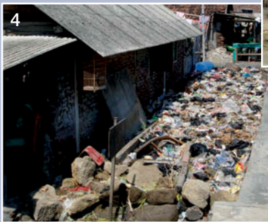
Die Fotos 1 bis 5 verdeutlichen das dramatische Ausmaß der Absenkung von Gebäuden und dokumentieren die verzweifelten Versuche, mit einfachsten Mitteln – Erde, Schutt und sogar Müll – dagegen anzukämpfen.
