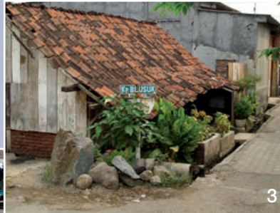
Die Fotos 1 bis 5 verdeutlichen das dramatische Ausmaß der Absenkung von Gebäuden und dokumentieren die verzweifelten Versuche, mit einfachsten Mitteln – Erde, Schutt und sogar Müll – dagegen anzukämpfen.
