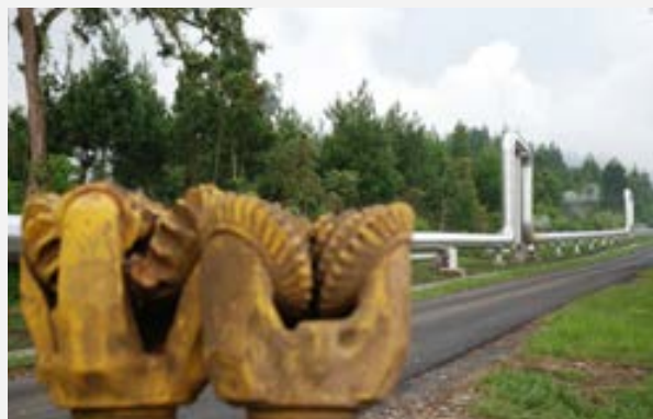
Leitungen des 200 MW Geothermiekraftwerks Kamojang, West Java.
