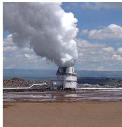
▲ Reservoir-Test auf einer neuen Bohrung im Bohrfeld Menengai in Kenia.
