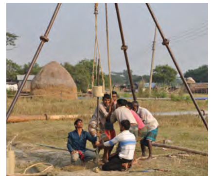
▲ Sondierungsbohrung zur Ermittlung des Baugrunds.
