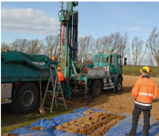
▲ Einsatz des Bohrgeräts für die Beprobung des Bodens bis zum Grundwasser.
