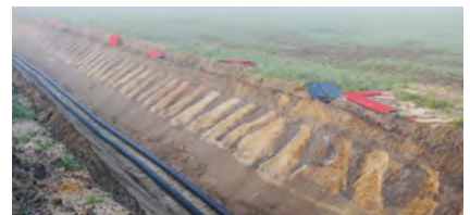
▲ Kabelgraben einer Erdkabeltrasse in Niedersachsen.
