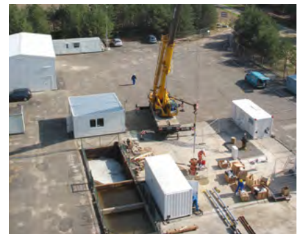
▲ Bohrplatz Horstberg während des Einbaus einer Förderpumpe.
