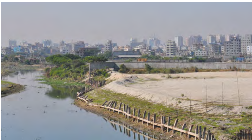
▲ Durch Sandaufschüttung entstehen am Rand der Hauptstadt Dhaka neue Bauflächen.
