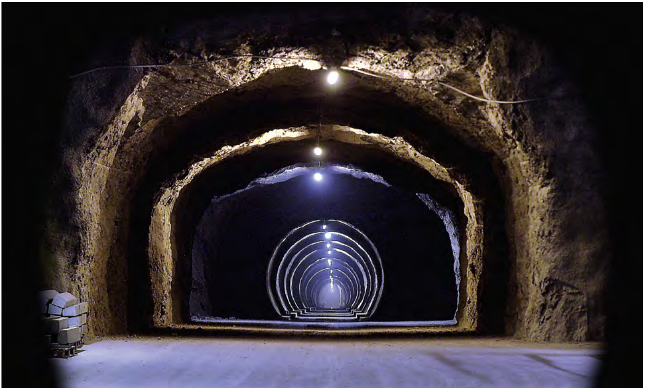
▲ Sondierstollen im internationalen Felslabor Mont Terri in der Schweiz. Die BGR erforscht dort seit 20 Jahren die Eigenschaften von Tonstein für ein Endlager.
